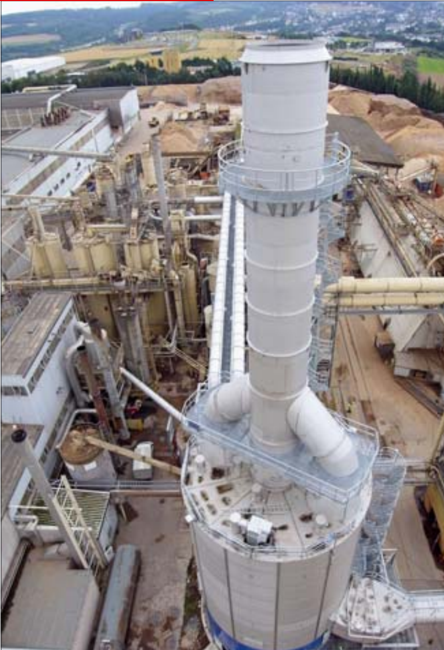
Bei der Herstellung von Spanplatten setzt die Firma Glunz in Kaiseresch unter anderem Spänetrockner und Biomassefeuerungsanlagen ein. Deren Abgase werden seit 2008 von dieser EWK Umwelttechnik-Anlage gereinigt, die rund 380.000 Kubikmeter in der Stunde schafft.
