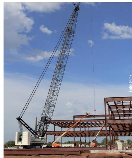
HC 285 im Einsatz: Das neue Terex-Modell musste auf der Baustelle bis zu sechs Tonnen schwere Bauteile heben.
